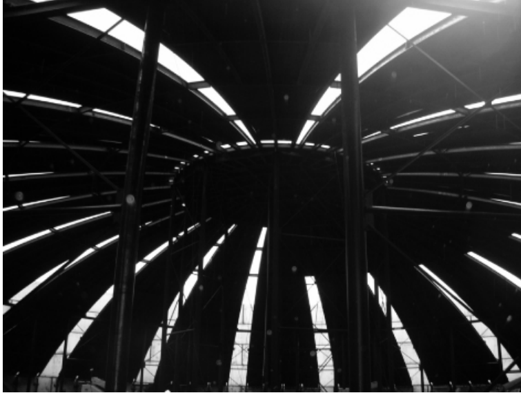
LNG Tank No. 1 Roof
